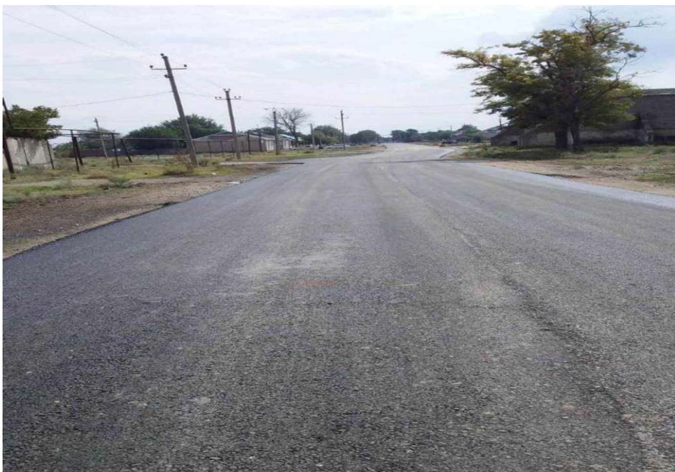
Рисунок 5 - Отремонтированное дорожное полотно на улице Октябрьской села Чернолесского Новоселицкого района
