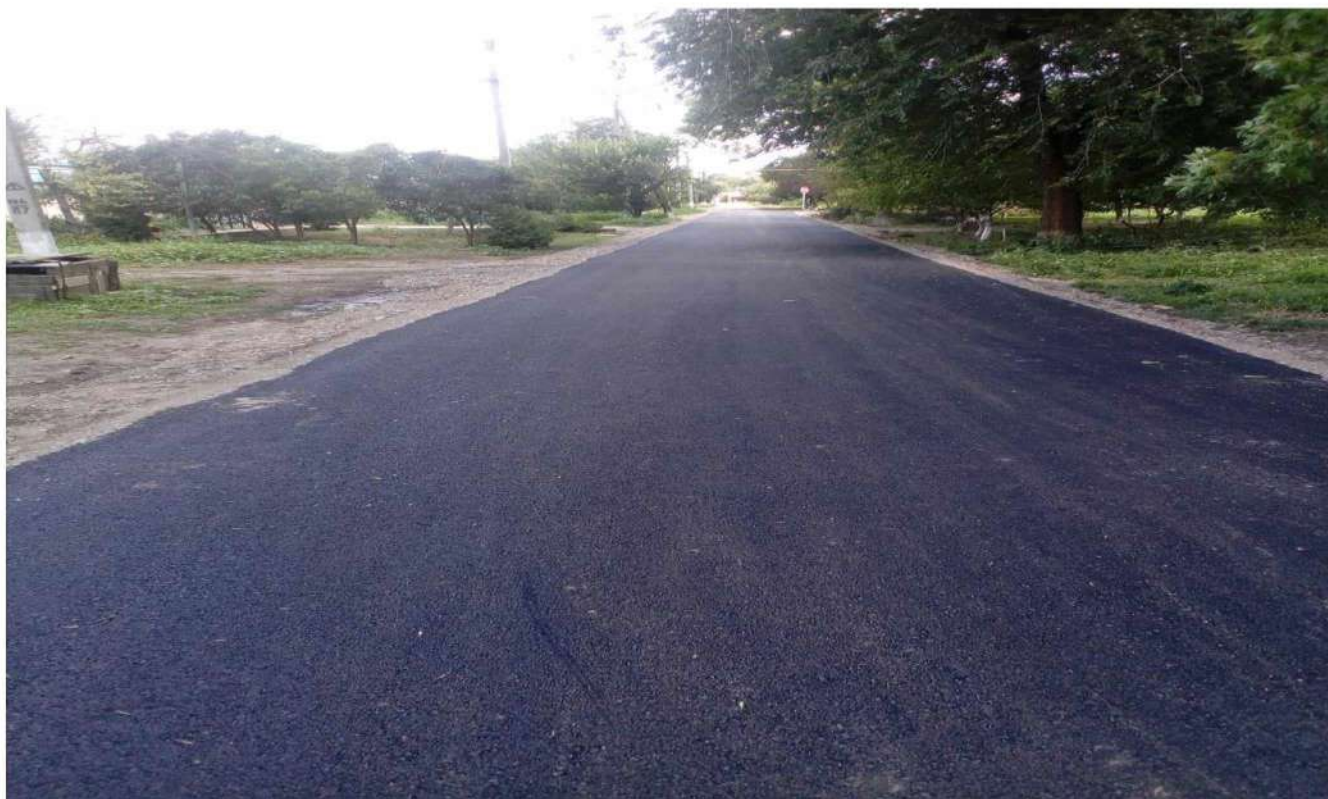
Рисунок 4- Отремонтированное дорожное полотно в селе Журавском Новоселицкого района
