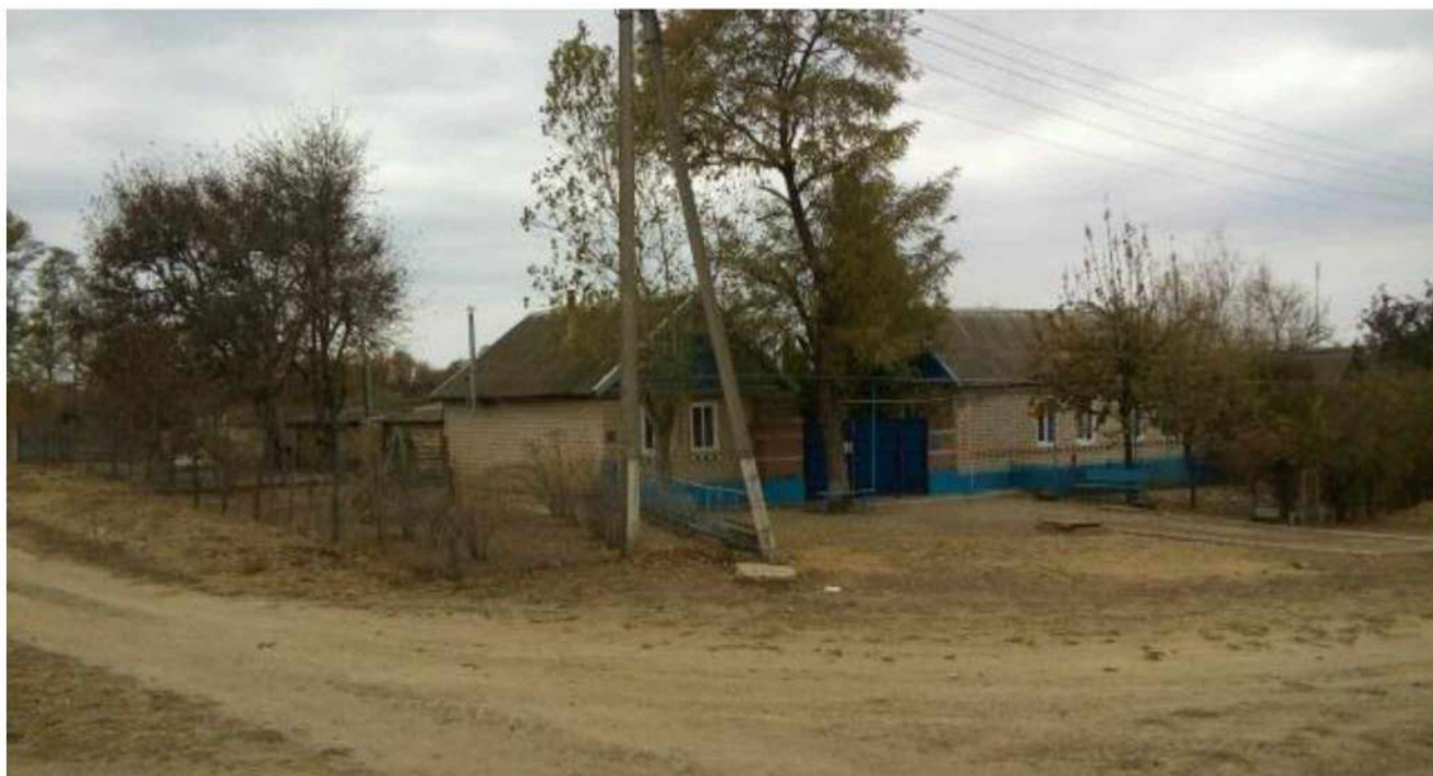
Рисунок 6- Состояние дорожного полотна на улице Садовая села Китаевского Новоселицкого района
